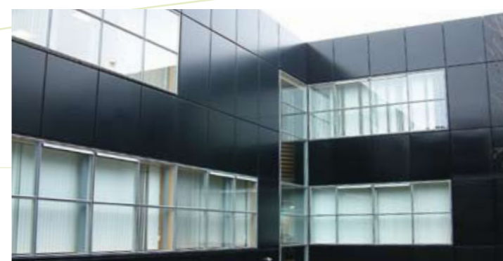
Bedrijfspannd Bose, linkerdeel nieuwbouw, rechterdeel oude panelen behandelt met Tedac
